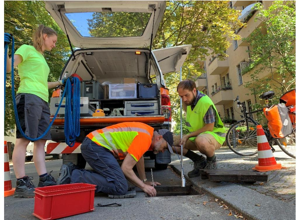
*Einbau des Spannrings und der Sensorik in einen Straßenablauf*
