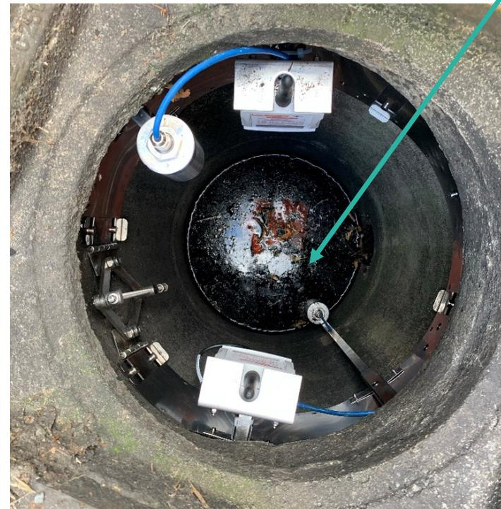
*Sendeeinheiten und Schwimmerschalter an Spannring befestigt. Unterer Schwimmerschalter misst Einstau direkt über Kanalverbindung, oberer Sensor misst kurz vor Überflutung der Straße.*
